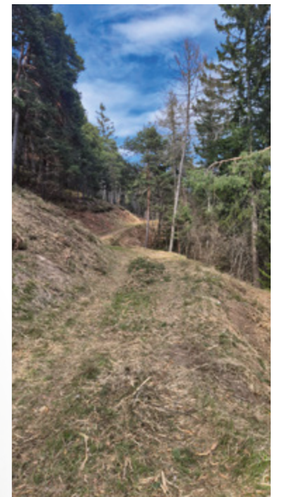
Manutenzione strada Doss da Begia.
